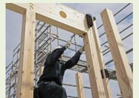
積水ハウス建設による高精度な施工
