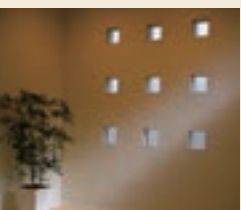
独立性の高い部屋を囲む(壁)。室内窓を設ければ、明るさや気配が伝わります。
