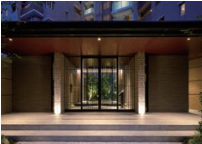
エントランス両サイドの壁面はあえて暗めにして、エントランス前の床から風除室の床そして中庭へと続いたあかりによって中へ視線を誘導しています。(GM百道浜Villa/福岡県)
