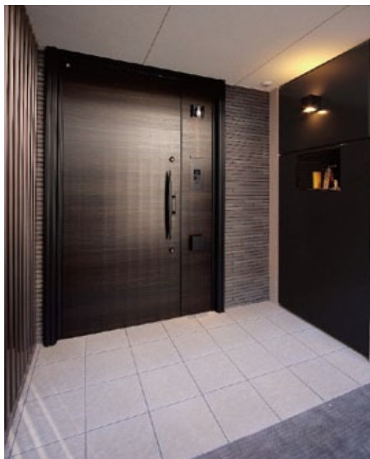
わが家らしさを演出できるように、玄関柱のポーチにウェルカムボックスをしつらえ、またボックスの下部には傘を収納できるほか、メーターボックスとしての役割も果たしており、機能性にも配慮しています。(GM大塚公園2011/福岡県)
