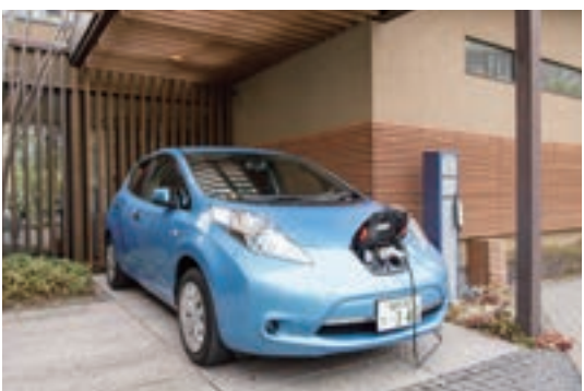
EV車用の充電システムを利用する電気自動車。これからのEV時代に対応したシステムとして、来客用駐車場などに専用の充電スペースを設けるGMも多くなっています。(GM千早中央丘/福岡県)
