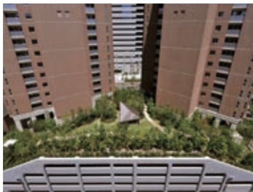
人工地盤の中に3階建ての自走式駐車場を設けた珍しい例です。駐車場上の公園は、住まう人たちの憩いの場となっています。(GM百道浜Viera&フォレスト/福岡県)
