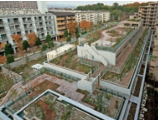
総戸数246戸の大規模マンションでありながら、駐車場設置率100%を確保。住戸棟に囲まれるように建つ駐車場の屋上には里山を手本にした庭園をつくりました。(GM千早中央丘)
