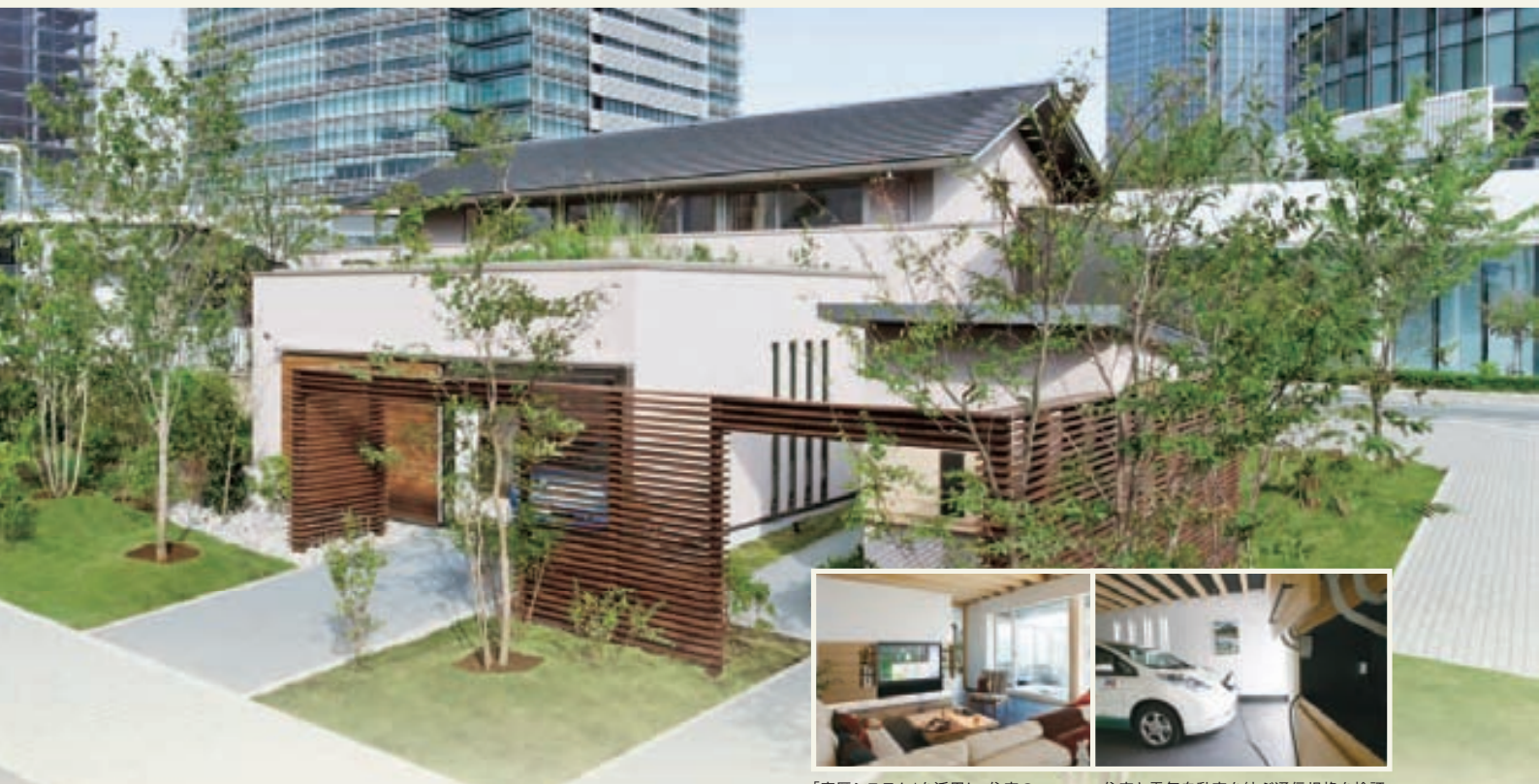
横浜みなとみらい21地区に建設した実験住宅「観環居」 木造住宅「シャウッド」で建築/延床面積 266.28㎡
