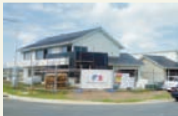
瓦一体型太陽発電システムを搭載した ディスプレイホーム
