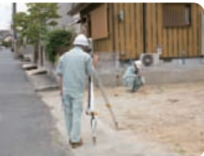
敷地調査で、ガス・水道の引き込み箇所をチェック
