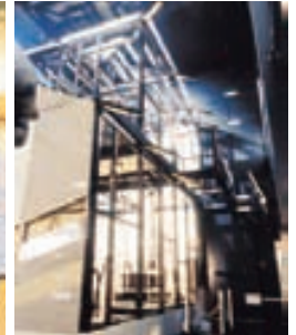
実物大カットモデルで、構造体の 見えない部分を確認
