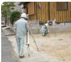
敷地調査で、ガス・水道の引き込み箇所をチェック
