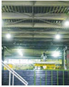
水銀灯による全体照明を、蛍光灯の手元照明に
