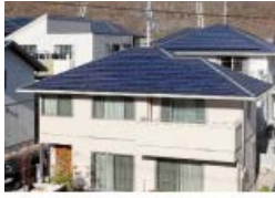
まちなみに配慮した瓦一体型 太陽光発電システム
