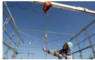
足場上部に現場仮設型天井クレーンを設置し、 躯体・外装工事を施工する。 オリジナルの「ガータークレーン」
