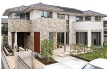
太陽光発電システムを5.2kw搭載
