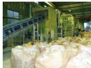
栗東資源循環センターのリサイクル材製造ライン
