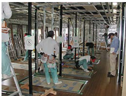
内装施工の実技試験。複数の検定員が評価
