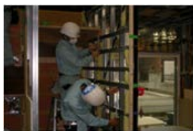
「内装課程」の階段施工実習
