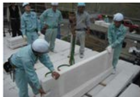
「普通課程」の現場実習(建方)
