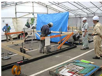
基礎施工の実技試験。合格するには、高いレベルの技術が必要
