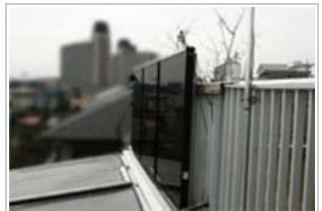
ソーラーシステム実証実験 屋上手すり外側に温水パネルを設置
