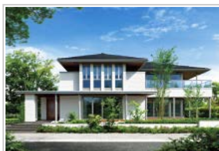
鉄骨2階建て住宅「イズ・ロイエ」
