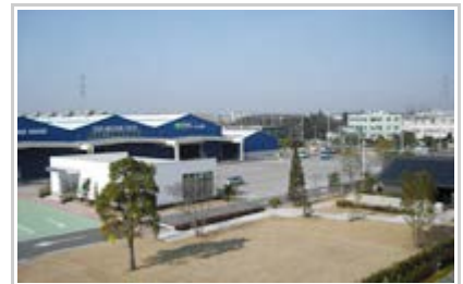
「ゼロエミッションセンター」全景 画面右が「ゼロエミッションハウス」 左の白い建物は「ウェルカムホール」 左奥は「資源循環センター」
