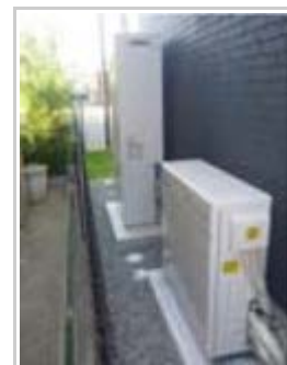
発電時の熱で貯湯できる燃料電池を装備
