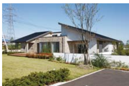
16.3kWの太陽光発電システムを搭載したコミュニティセンター。停電時に日中最大4.5kWの電力を供給します
