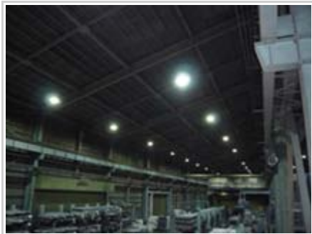
（照明機器変更）天井照明のLED化
