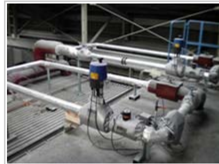
（被熱防止対策）蒸気配管の保温
