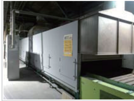
（熱損失対策）塗装乾燥炉表面に断熱塗装塗布
