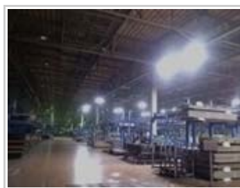
（照明機器変更）水銀灯から高効率照明へ
