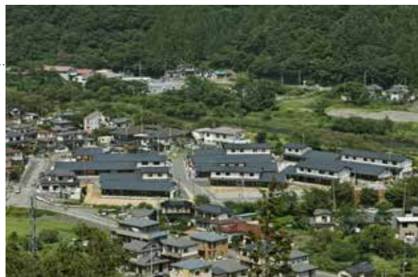
岩手県大槌町「災害公営住宅」
