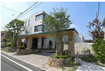
既存樹や井戸などを利用したエクステリア計画。石積みなど経年美化していく素材も使っています。
