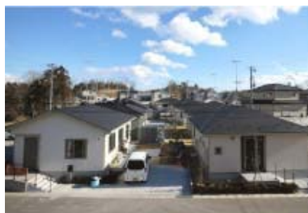
福島県新地町の災害公営住宅
