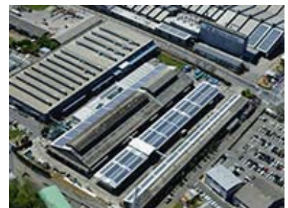
全国5工場で合計設置容量6.7MWのメガソーラー稼働
