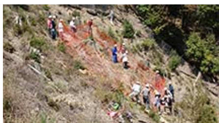
古くなった階段の補修作業
