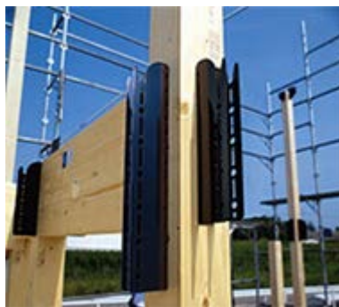
木造住宅「シャーウッド」では、強い躯体に組み上げる独自の接合システムを採用
