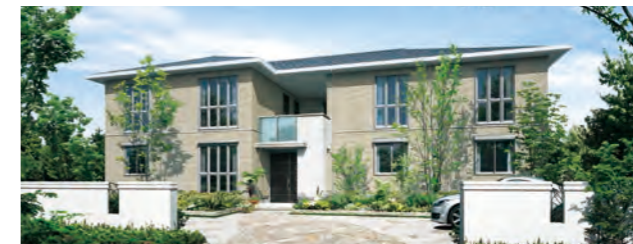
2階建て賃貸住宅「プロムープ」
