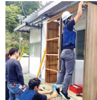
風除用の壁の取り付け
