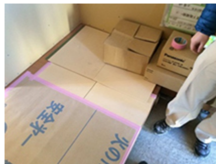
レンタル床養生シートの使用例
