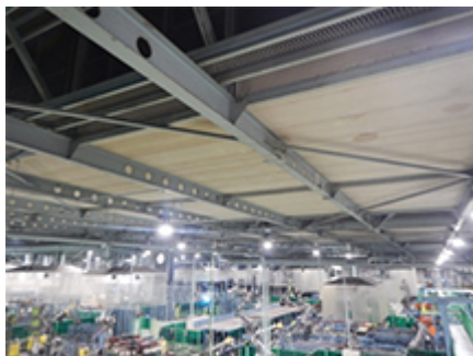
照明のLED化（第3工場）
