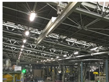
夜間稼働する工程の照明をLED化
