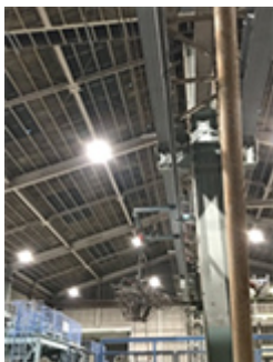
天井照明・屋外灯のLED化
