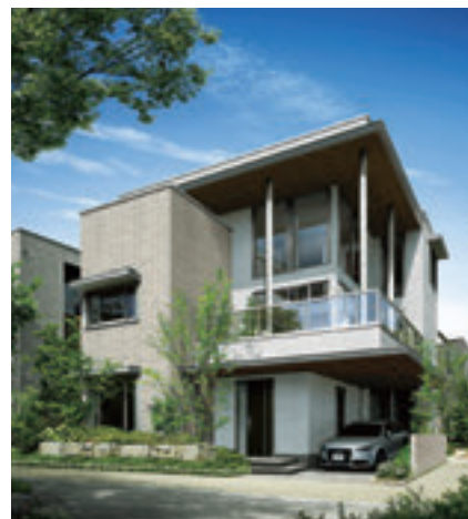
2層上の大屋根を支えるピロティ柱により開放的なバルコニー空間と大容量太陽光パネル設置を両立
