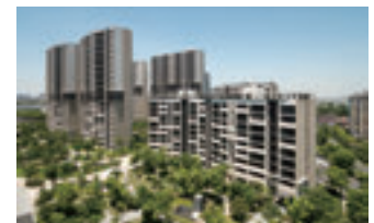
環境配慮建築としても高く評価されている 太倉裕沁庭
