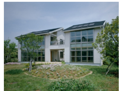
ケミレスプロトタイプ認証1号を 取得した積水ハウスの実験住宅
