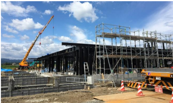
全体を複数の工区に分け、部材搬入と施工人員を配置することで作業効率化と短工期を実現
