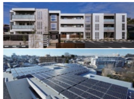
ZEH仕様の積水ハウスの賃貸住宅「シャームゾン」の実例 (埼玉県さいたま市)
