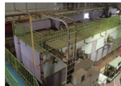
乾燥炉扉の外張り断熱
