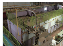
乾燥炉扉の外張り断熱
