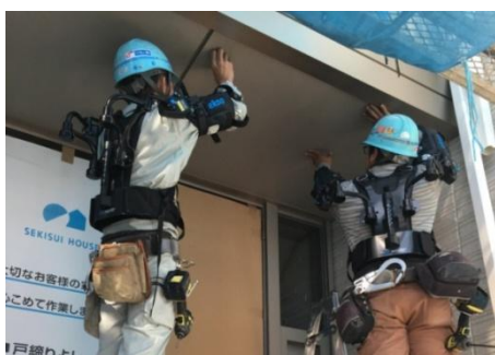
軒裏取り付け、継続的な上向き作業の負担を軽減
