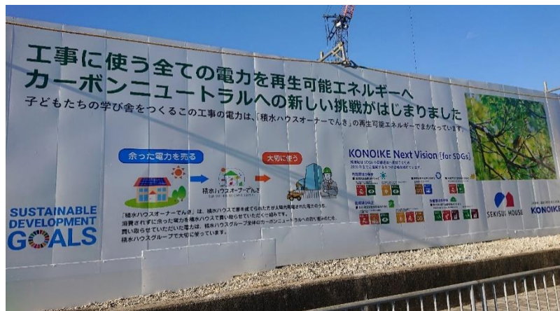
今回の取り組みを説明する施工現場の仮囲い
