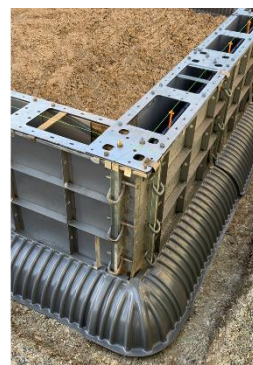
専用の基礎型枠とアンカー定規を使用 高精度な施工
