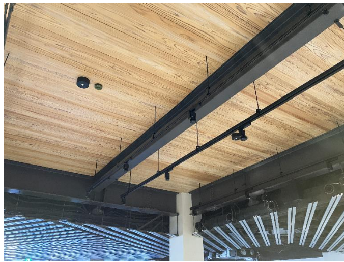
▲公園施設天井デッキ
