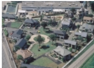
住まいの夢工場（関東工場）
