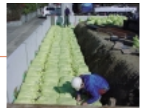
環境に配慮したソルパック工法 (P.26)
