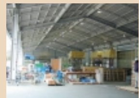
拡充されたリサイクルセンター
