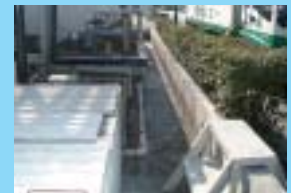
排水処理施設の防油堤
