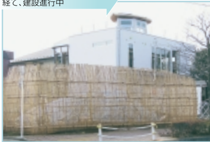
竹の廃材を有効利用したユニークな工事用仮囲い
