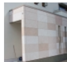
廃ガラスの多孔質軽量建材 の外壁利用
