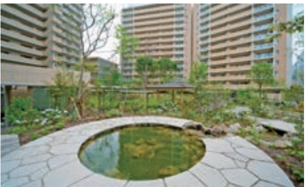
都市の中でエコな生活を意識できる環境配慮型マンション。雨水タンクを中庭の地下に埋設。災害時の生活用水として利用できるほか、普段は敷地内の小川や植栽への散水に利用しています。(GM西九条BIO/大阪府)
