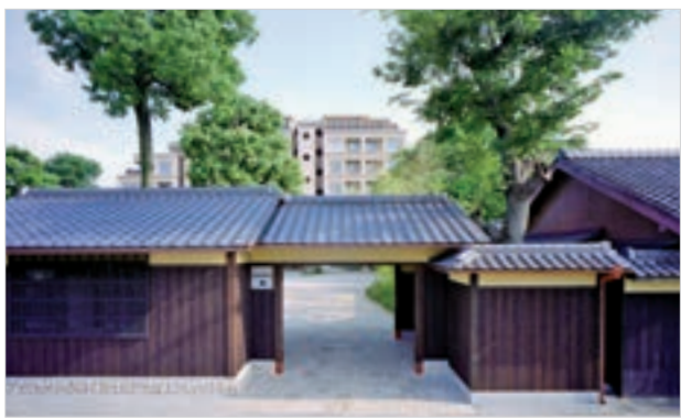
もとは名古屋の著名な実業家の別荘として建てられた白壁櫻明荘。その後持ち主が変わって料亭になったときにも残されていた見事な長屋門や庭をGMにも受け継ぎました。(GM白壁櫻明荘/愛知県)
