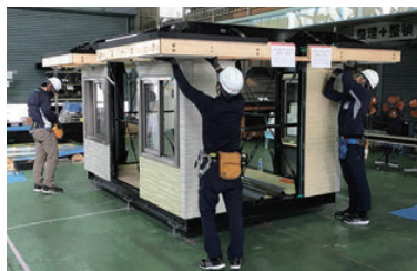
躯体外装コース 修了試験風景
