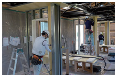
内装施工コース 修了試験風景
