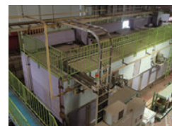
乾燥炉扉の外張り断熱
