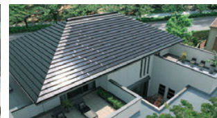
積水ハウスオリジナルの 瓦型太陽光発電パネル
