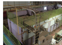
乾燥炉扉の外張り断熱
