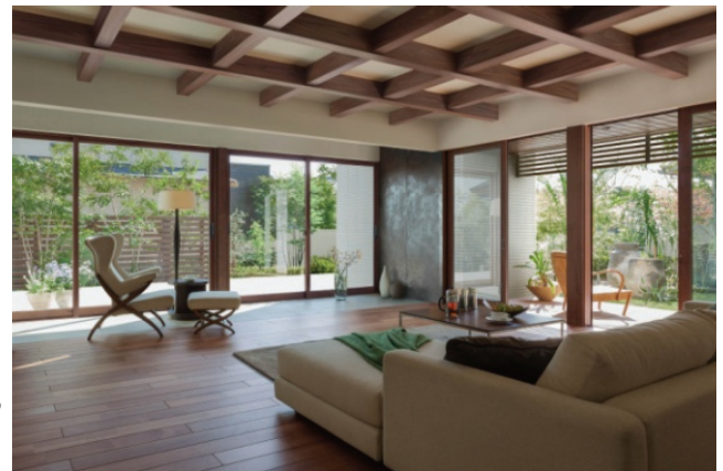
高いデザイン性と強度を両立する 「大スパン格子状床梁」「あらかし内装」 (1階・天井)
