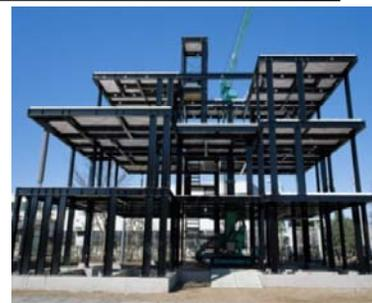
「βシステム構法」で組み上げられた構造躯体
