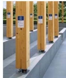
柱と基礎を土台を介さず直接緊結
