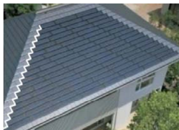
モジュールにあわせた瓦型の太陽電池の採用により、屋根の形状を選ばず隅々まで設置が可能
