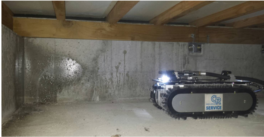
建物外から床下の施工ロボットを遠隔操作して防蟻処理の薬剤を散布
